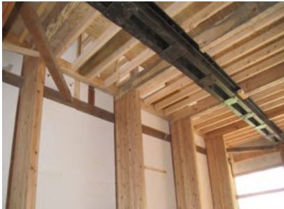
木造校舎耐震改修
