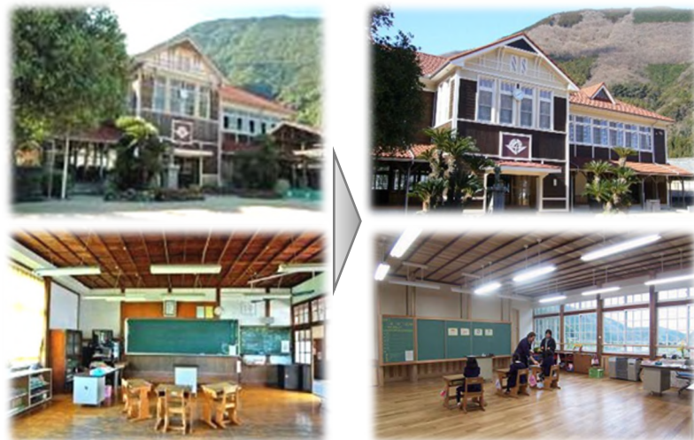
A小 木造・築79年⇒徹底的なエコ改修
