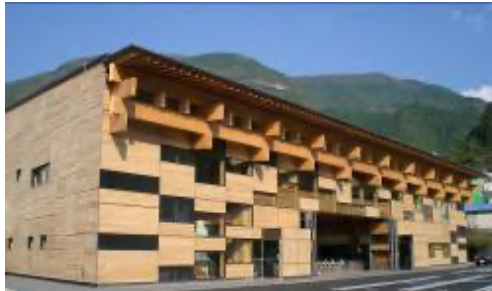
栲原町総合庁舎 CASBEE S、LCCO 2 40%減 公共建築賞（国土交通大臣賞）
