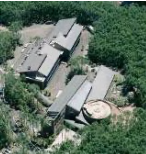
山梨県環境科学研究所 CASBEE S、LCCO 2 30%減 環境省エネ建築（建設大臣賞）
