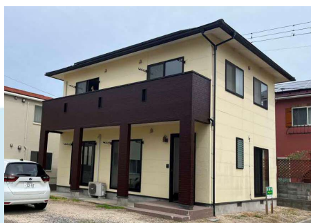
<改修前の外観>
