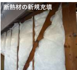
断熱材の新規充填
